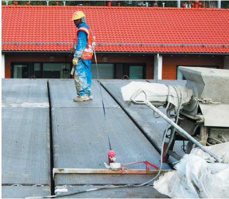
Kuva 3. Laatta-asennuksessa on käytettävä henkilökohtaista putoamissuojausta.
