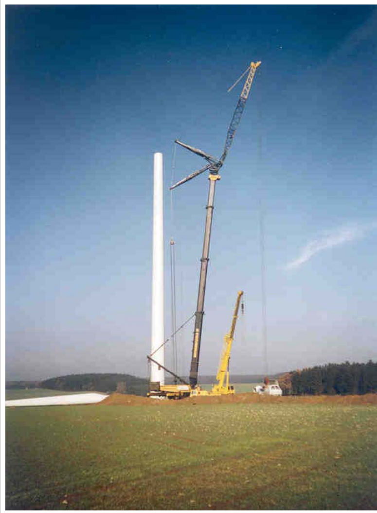
Tuulivoimalan pystytys, Saksa 2002
